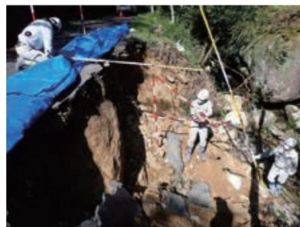
河川の増水によって河床が洗掘され、護岸が崩壊した現場。私達は、復旧するための災害調査を行っています。
